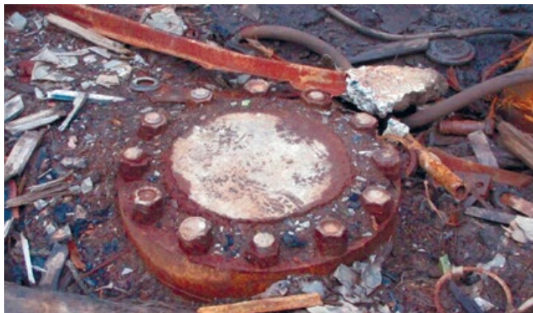
Фото 5. Устье Кольской сверхглубокой скважины. Современное состояние.
